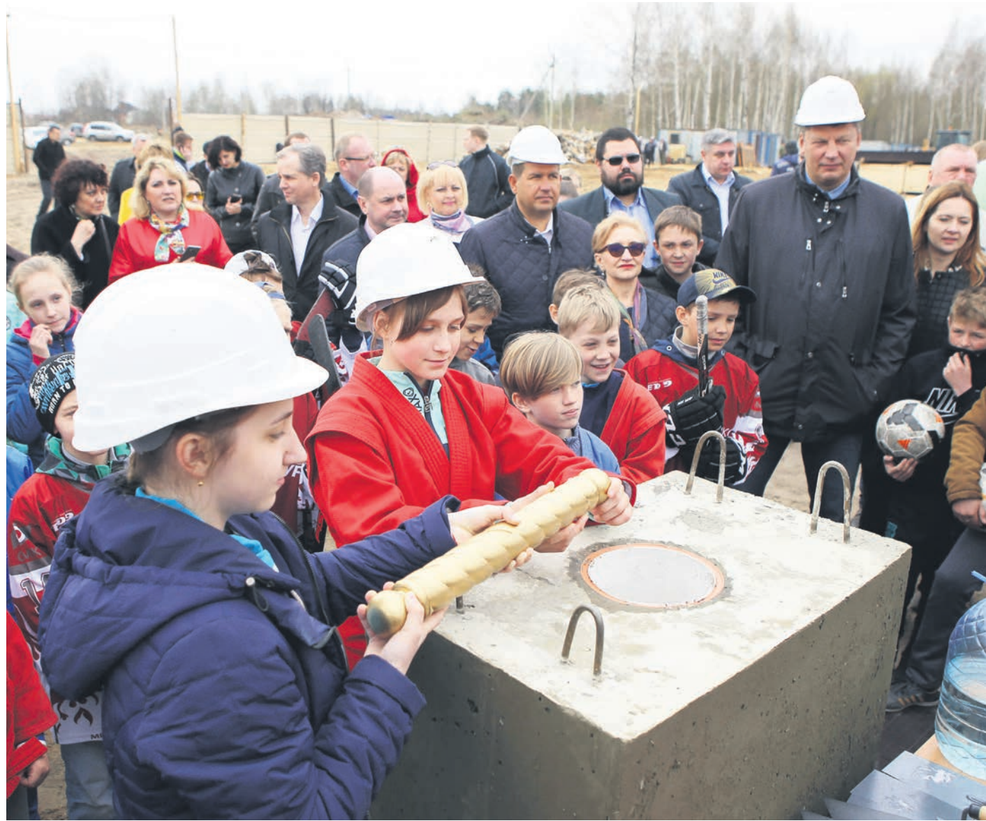
▲ В фундамент будущего здания заложили «капсулу времени» с посланием для потомков © ВАЛЕРИЙ ПОКУМЕЙКО
