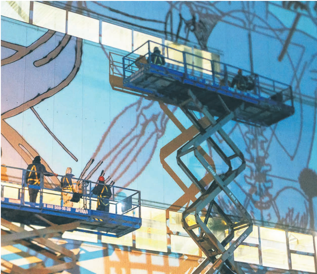
Δ На стене МКС-5000 уже можно разглядеть контуры будущего рисунка © АРХИВ ОМК
